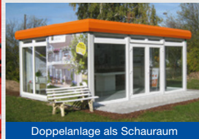
Doppelanlage als Schauraum
